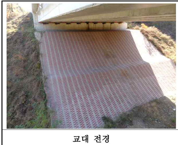
【사진 11.3.8】 교대 전경
