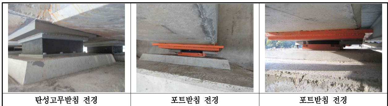
【사진 11.3.37】 교량받침 전경
