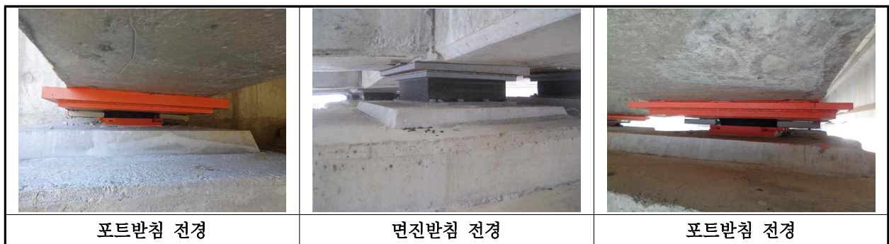
【사진 11.3.12】 교량받침 전경
