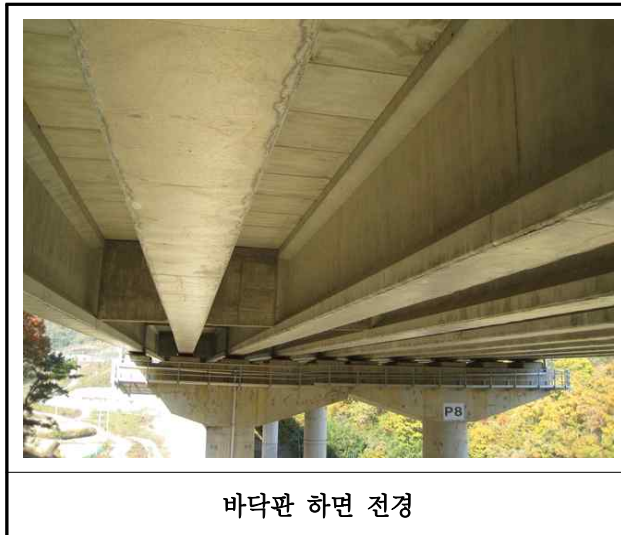
【사진 11.3.27】 바닥판하면 전경
