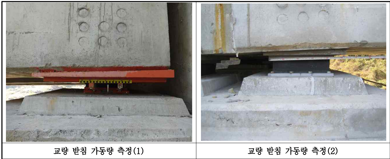
【사진 11.3.15】 교량받침 이동량 측정
