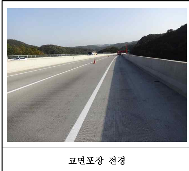
【사진 11.3.44】 교면포장 전경
