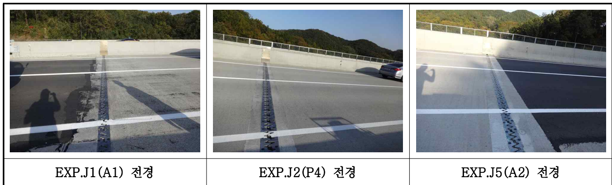
【사진 11.3.41】 신축이음장치 전경
