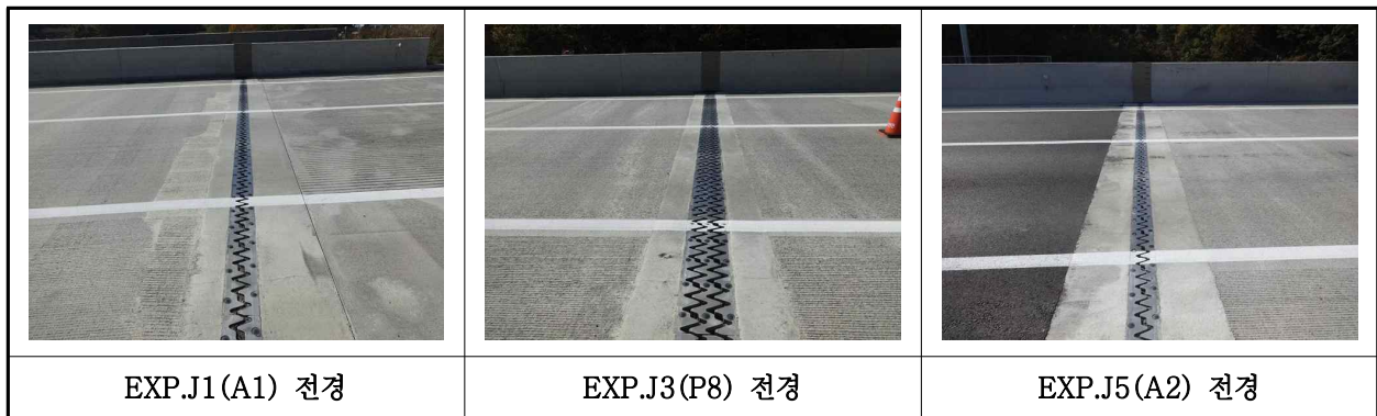
【사진 11.3.16】 신축이음장치 전경
