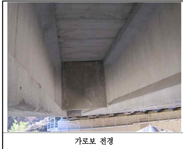
【사진 11.3.6】 가로보 전경
