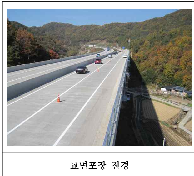
【사진 11.3.19】 교면포장 전경
