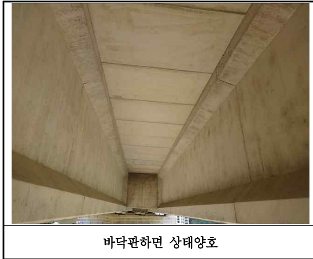
【사진 11.3.28】 바닥판하면 손상현황
