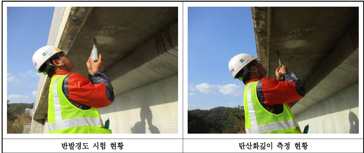
【사진 11.4.1】 콘크리트 내구성조사 현황
