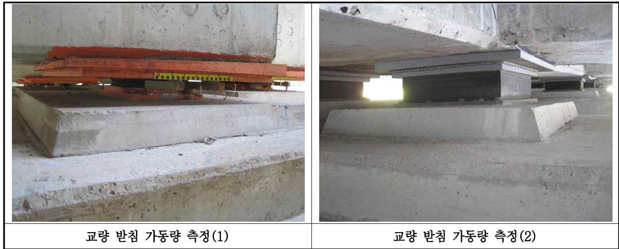
【사진 11.3.40】 교량받침 이동량 측정
